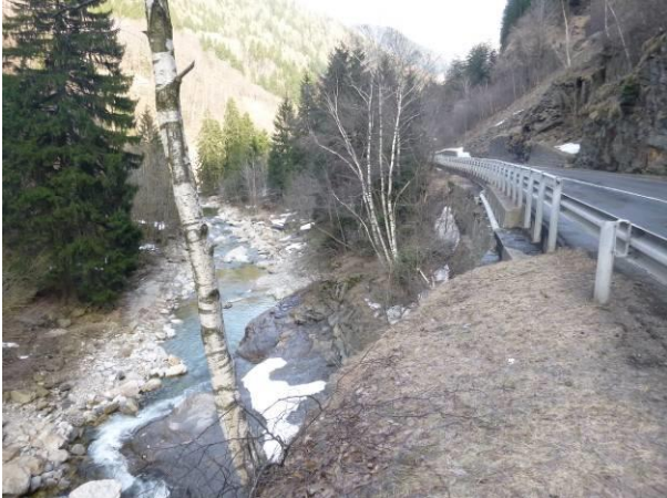
Fehlender Bürgersteig an der Kantonsstrasse
