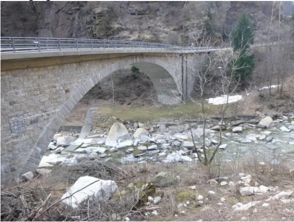
Durchgang unter der Kantonsstrasse
