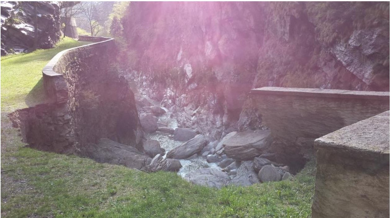
Historische Strasse nach dem Einsturz vom Frühjahr 2013
